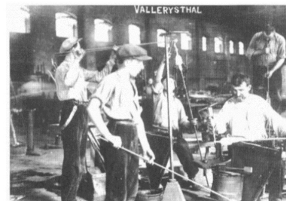
Une place de verrier : le souffleur, le cueilleur, le poseur de jambe chef de place, le poseur de pied.
